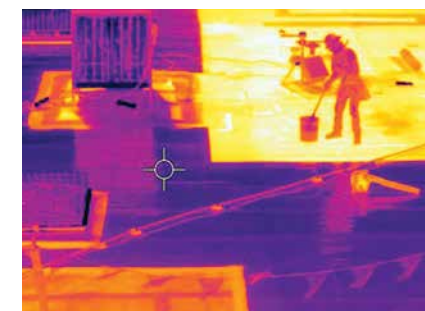
Una imagen térmica tomada durante una instalación de SkyCool muestra las áreas tratadas (blanco, amarillo), que son aproximadamente 35 °C más frías que el resto del techo.
